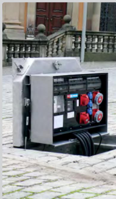
UNTERFLURVERTEILER
