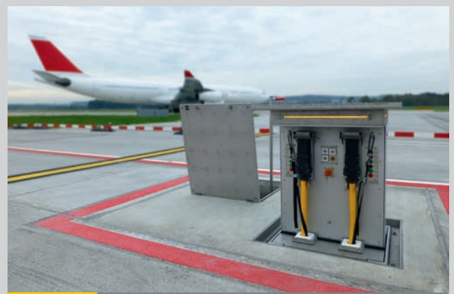
Remote SE100 Pit mit elektrischem Kabelförderer
